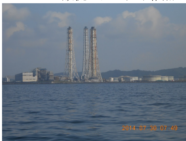
No.45 横須賀の東京電力火力発電所前の放流場所
