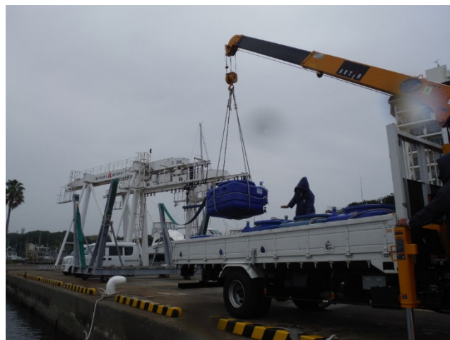
No.14 小網代のシーボニアマリーナの岸壁にてクレーンで ダンベイごとポンツーンに降ろす
