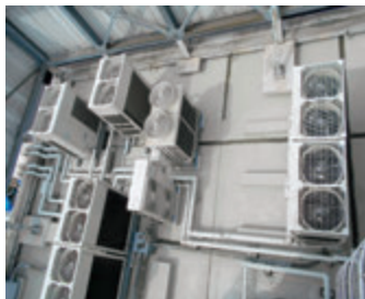
屋上床下地補修施工完了
