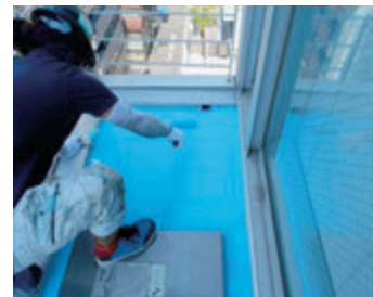
ベランダ防水工事
