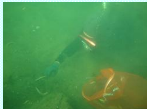
なぎさ公園での水中作業
